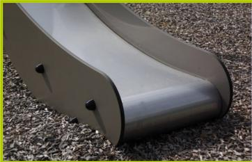
9- **Die Rutschflächen** sind aus 2 mm dickem Edelstahlblech, aus einem Stück gefertigt, gekantet und gebogen.
